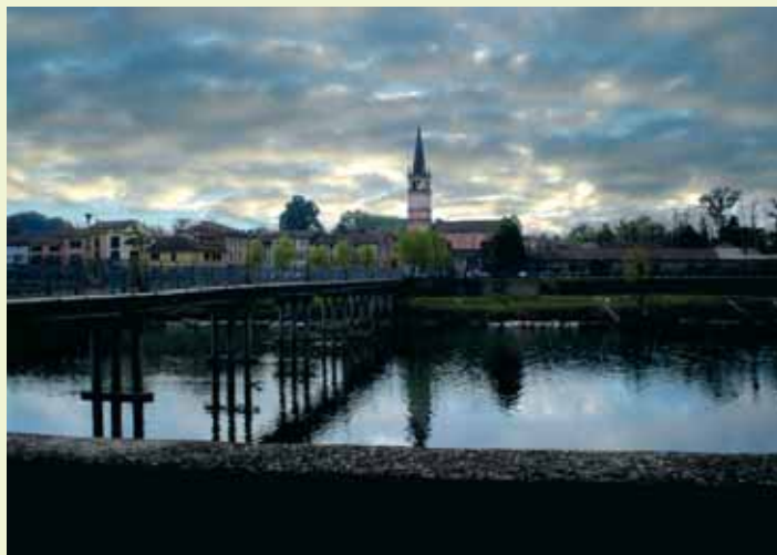
Il ponte ciclopedonale di Pizzighettone
