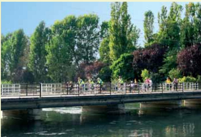
Il ponte sul canale Muzza a Conterico
