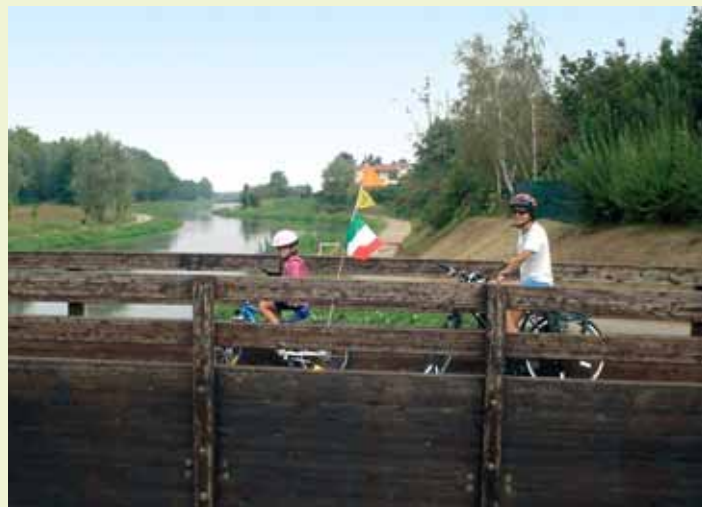
Il ponte ciclopedonale a Quartiano
